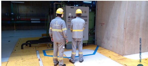
Inspeção em quadro de comando.
