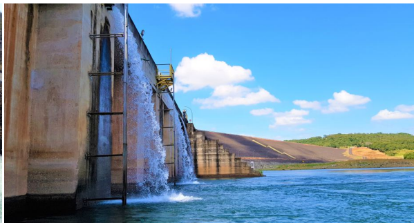
Canal de Fuga da UHE Amador Aguiar II
