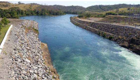
Canal de Fuga da UHE Amador Aguiar I
